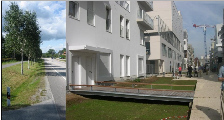
Figur 18. Exempelbilder på svackdiken (Foto: Sweco).
