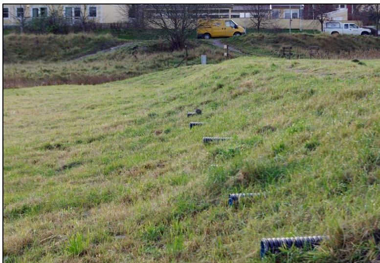
Figur 16. Exempel på torr översilningsyta (Andersson et al., 2013).
